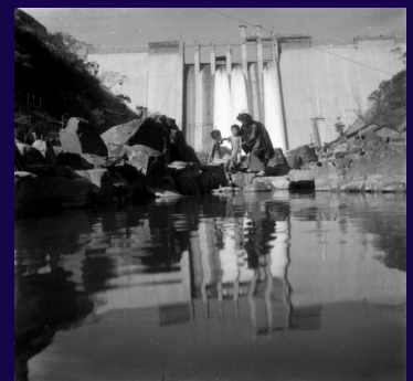
完成直前ダム
