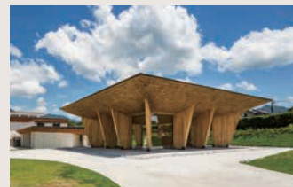
GREENable HIRUZEN (サイクリングセンター) ©Kawasumi-Kobayashi Kenji Photograph Office
